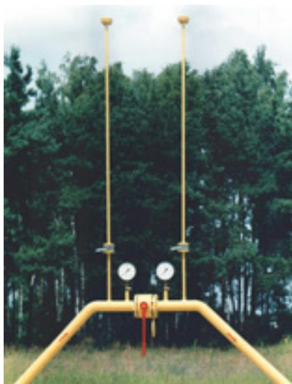
Запорно-сбросные системы монтируются на газопроводах низкого, среднего и высокого давления, а также на входных и выходных проводах газовых станции высокого и среднего давления.
